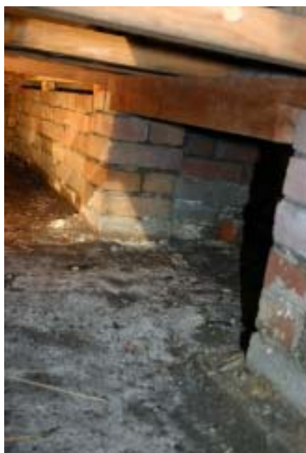
煉瓦束をコンクリート根巻きして補強
